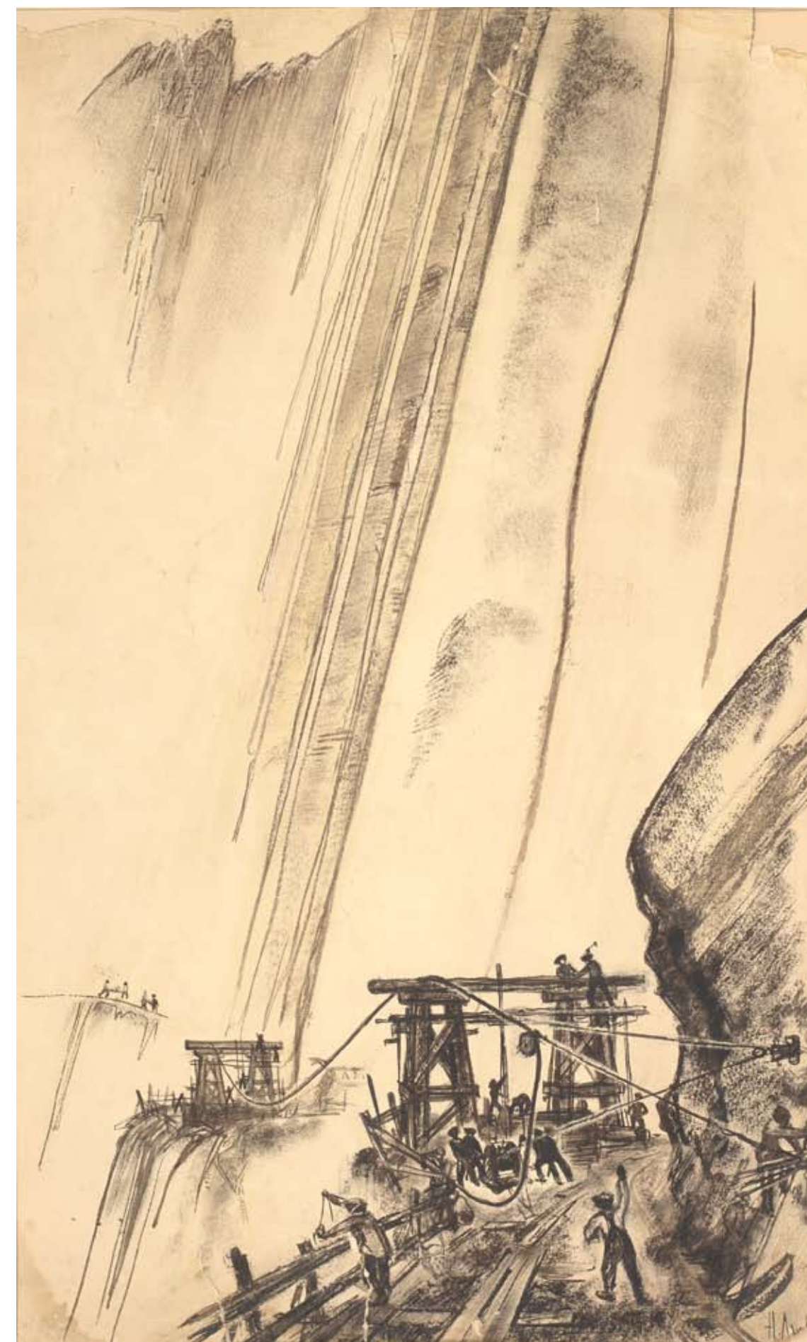
Из серии «Дагестан». «Гергебильстрой. Установка кабель-крана», 1930, бумага, тушь, 72×43,5 From the series Dagestan. «Gergebilstroy. Cable crane Installation», 1930, paper, ink, 72×43,5
